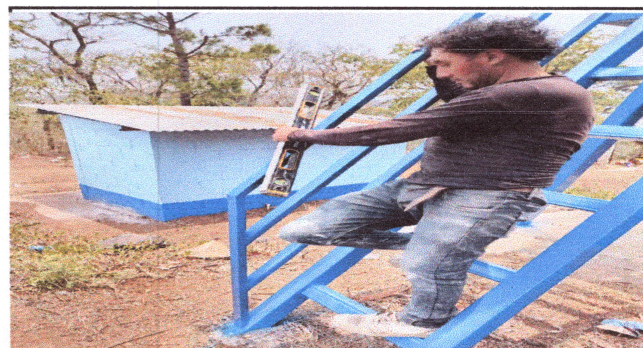
Foto: 6 Mantenimiento de depósito de agua.
