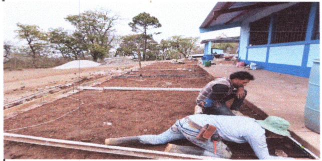
FOTO 2: Reparación de losa de patio.
