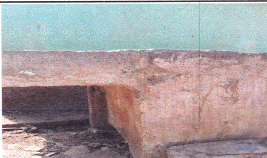
Foto: 5 Reparación de lavamanos, sistema de drenaje y agua potable.
