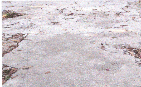
FOTO 2: Reparación de losa de patio.
