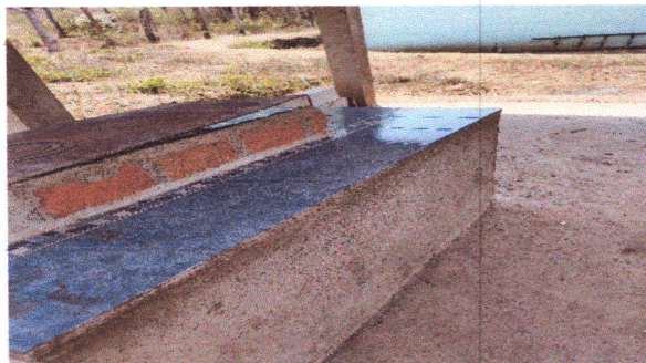
Foto3: Reparación de piso y sistema eléctrico
