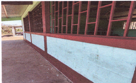
Foto1: Reparación de Pintura interior y exterior, sistema eléctrico, cuneta de concreto.
