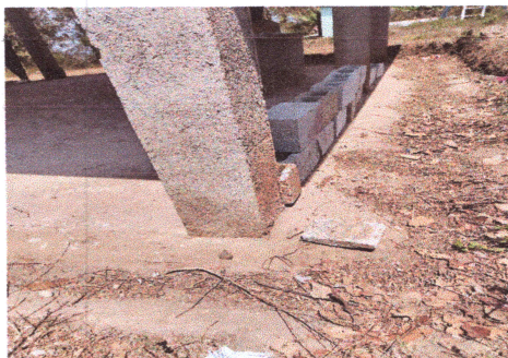
Foto4: Reparación de muros de cocina
