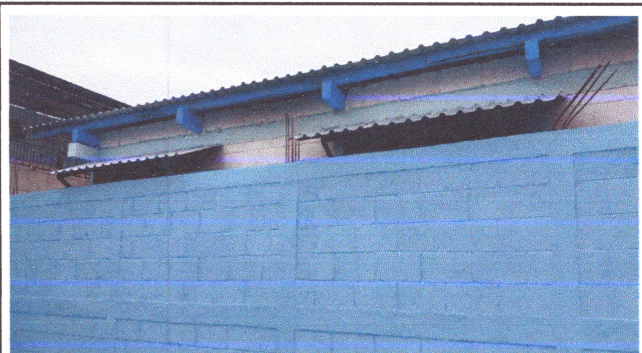
Foto 4: Pintura en paredes interior y exterior.
