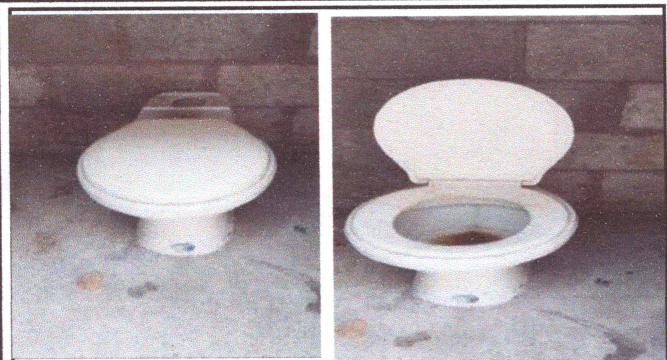
Sustitucion de Sanitarios
