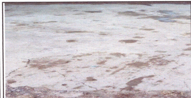
Reparación de Torta
