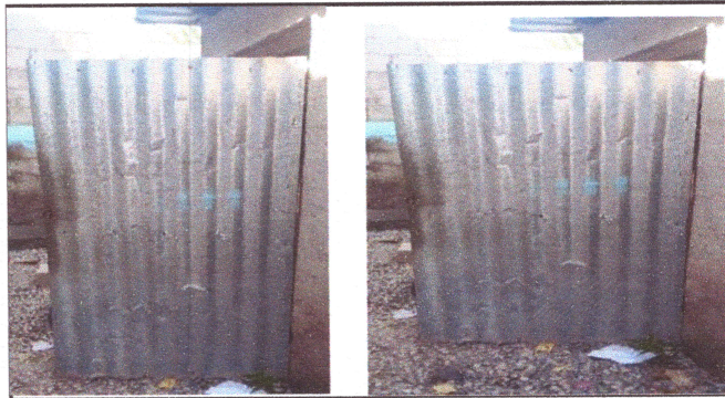
Cambio de Puertas de Baños
