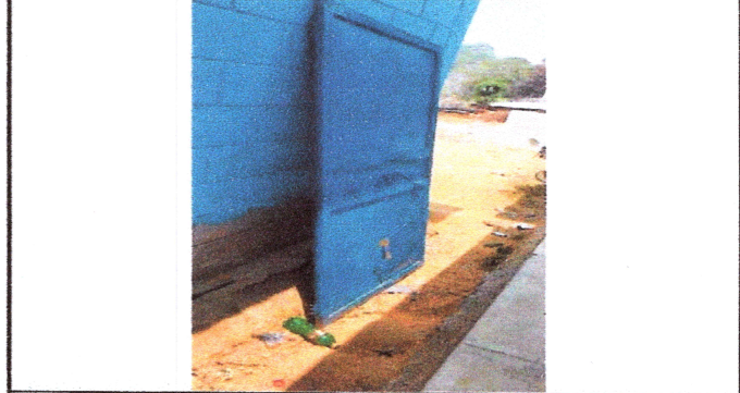
FOTO 2: Mantenimiento de puertas
