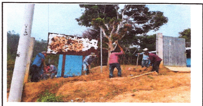
Foto: 6 mantenimiento a portones
