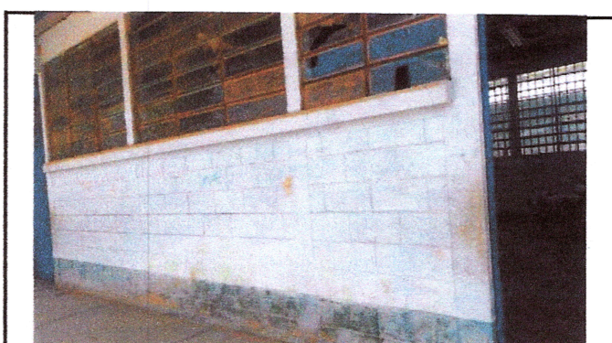
Foto4: Pintura en muros interior y exterior
