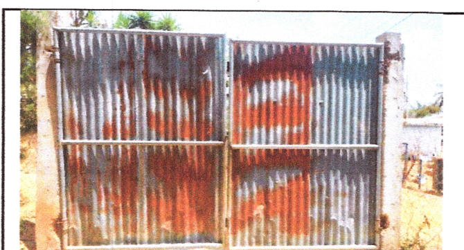
Foto: 6 mantenimiento a portones
