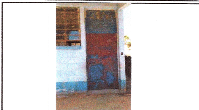
FOTO 2: Mantenimiento de puertas
