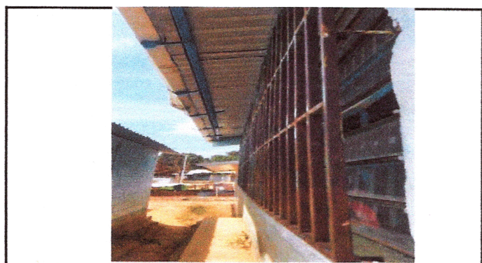
Foto3: Mantenimiento de balcones
