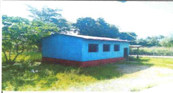
Foto 7: PINTURA EN MUROS INTERIOR Y EXTERIOR
