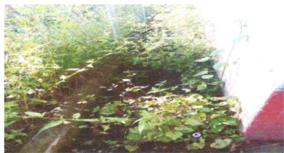
Foto 6: CUNETETA DE CONCRETO
