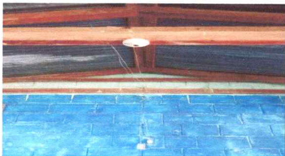
Foto 10: REPARACION DE SISTEMA ELECTRICO
