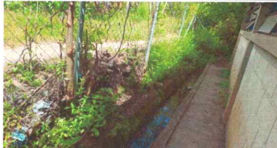
Foto 8: CERCO O MURO PERIMETRAL
