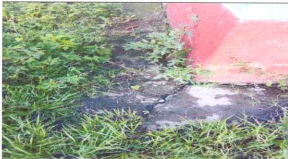
Foto 9: LOSA DE PATIO
