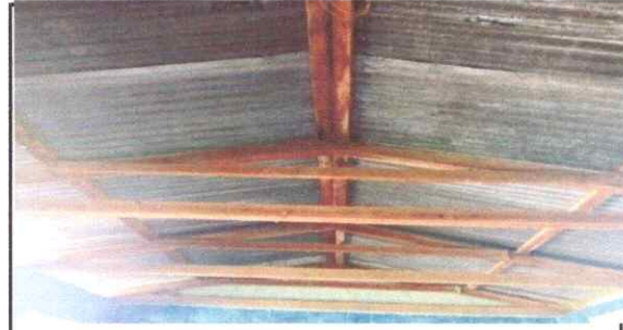
Foto 2: ESTRUCTURA DE TECHO
