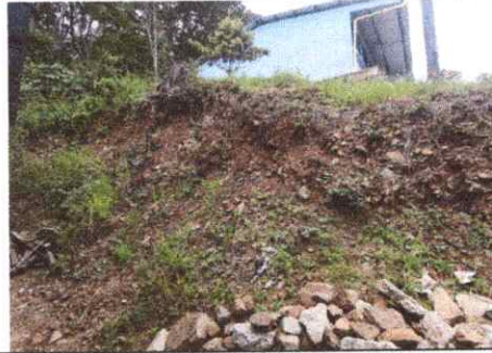
Foto 2: SUSTITUCIÓN DE CERCO PERIMETRAL CON BLOCK Y MALLA
