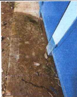
Foto 3: SUSTITUCION DE RED DE DRENAJES PVC6" INCLUYE ACCESORIOS
