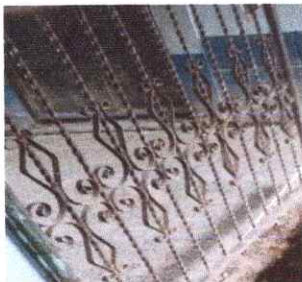
Foto 5: REPARACION Y MANTENIMIENTO A BARANDAS
