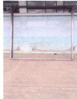
Foto 4: Sustitución de ventana
