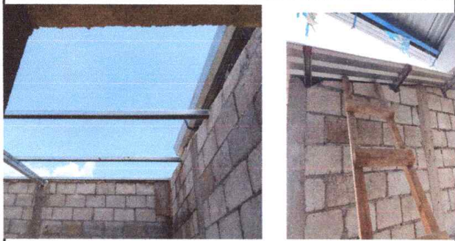
Foto1: Cambio de techo
