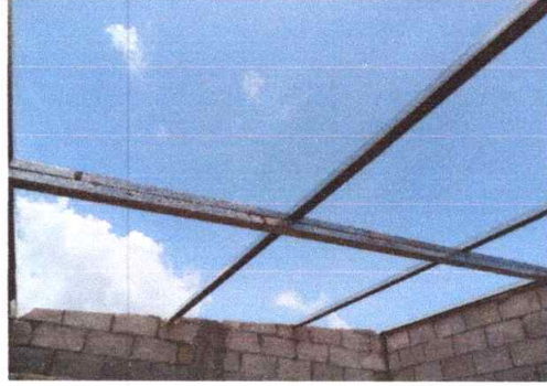
Foto 2: Cambio de estructura de techo
