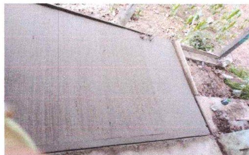
Foto 6: Reparación de cuneta
