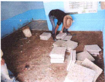
Foto 5: cambio de piso
