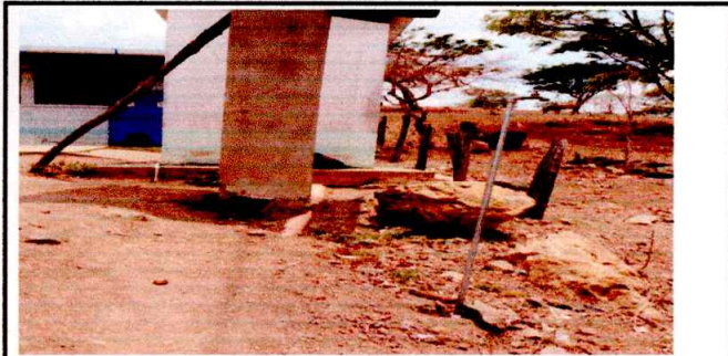
Foto 9: REPARACION DE RED DE DRENAJES Y RED DE AGUA POTABLE
