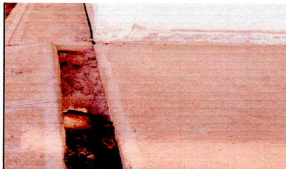
Foto 6: CUNETAS A REPARAR
