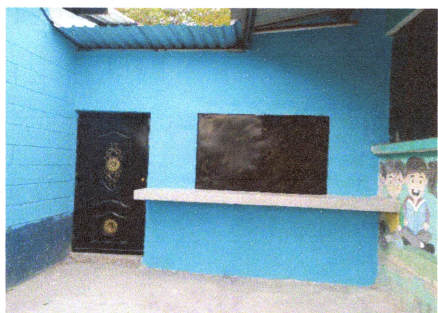
Foto 1: Puerta y ventana de cocina
