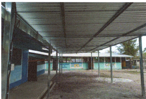
Foto 3: Parales y techo de galera
