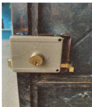
Foto 5: Reparación de Chapas de puertas
