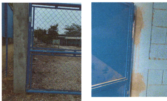
Foto 6: Reparación de Portón y Puertas
