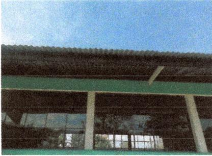
Foto3: Canales y bajadas de agua pluvial
