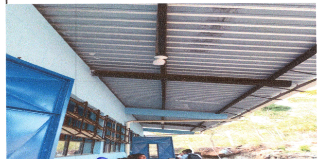
Foto 6: instalacion de alumbrado electrico
