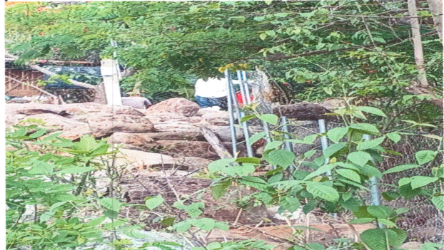
Foto 2: reparación de malla y colocacion de tubería
