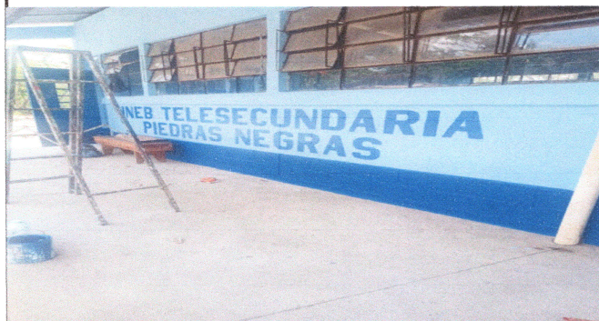
Foto 3: pintado interior y exterior. Colocacion de identificacion del instituto
