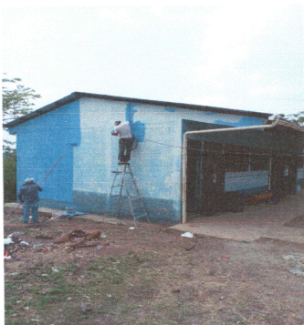
Foto 3: pintado de paredes de exteriores
