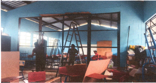
Foto1: reparación de puerta interna
