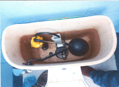
Foto 5: instalacion y reparacion de baños
