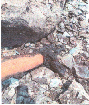
Foto 1: arreglo de tubería en mal estado
