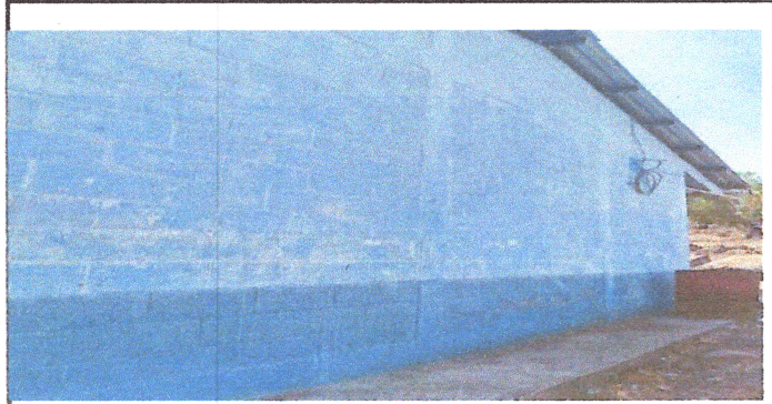
FOTO 2: pintura en muros interior y exterior 07-03-2024
