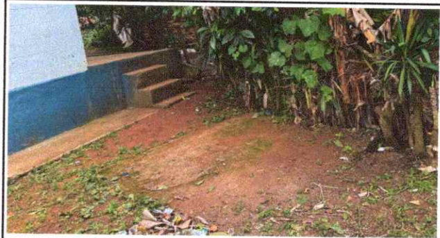
Foto 2: Reparación de la Losa del patio por deterioro.
