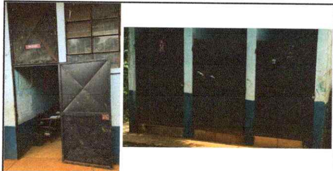
Foto 6: Mantenimiento a puertas de aulas y baños.
