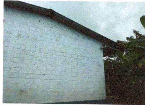
Foto 4: Pintura de muros internos y externos.
