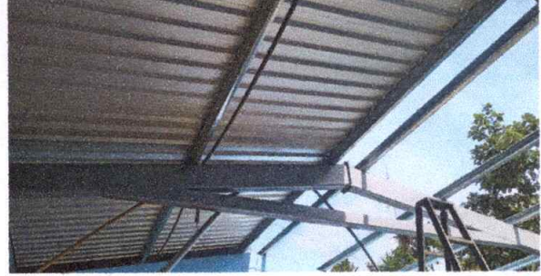
FOTO 2. Siguiendo con los trabajos de cubierta con la lamina
