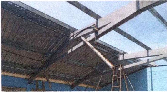
FOTO 1: Trabajando la cubierta de lamina 60%
