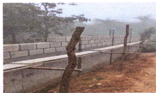
Foto 6: Muro perimetral en un 60% de avance
