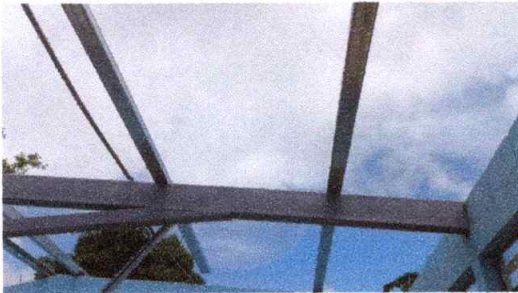
FOTO 3: Estructura de techo en la instalación
