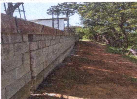
FOTO 5. Muro perimetral en el avance
