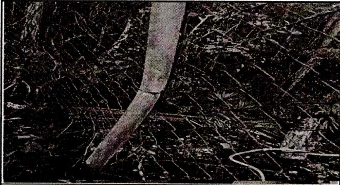
Foto 1: se observa quebrado el tubo de soporte en malla perimetrar
