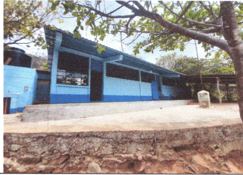
Foto 2: Pintura y losa de pario terminado
