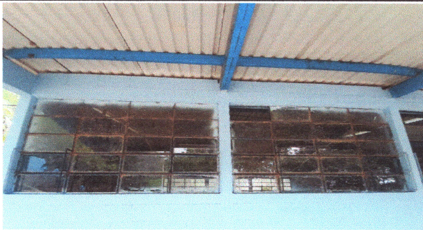
Foto 5: Reparacion de de vidrios de ventanales terminado
