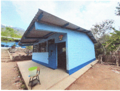
Foto 3: Pintura de muro exterior
