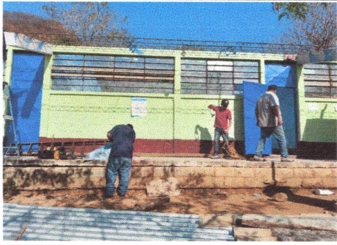
Foto 3: Colocoando los tubos en la sobre estructura antigua.
