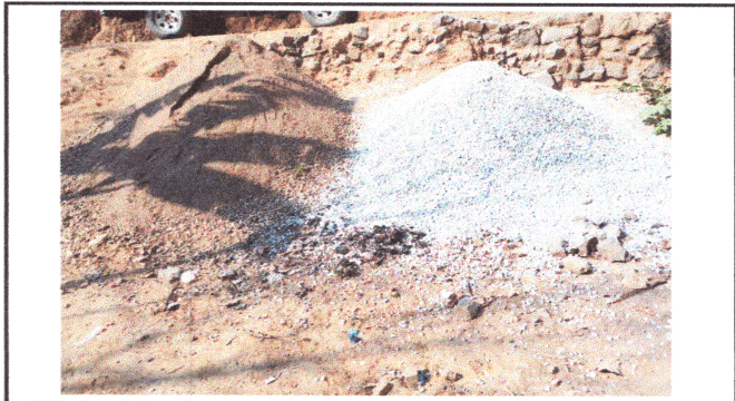
Foto 2: Material que se esta utilizando para la losa de patio
