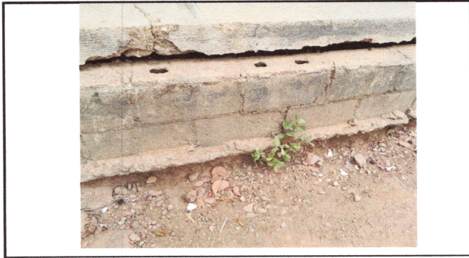
FOTO 2: Reparacion de losa de patio y contencion del corredor
