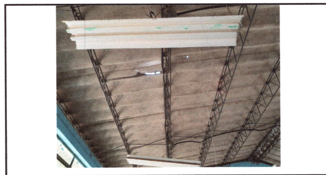
Foto: 6 Reparacion de sistema electrico
