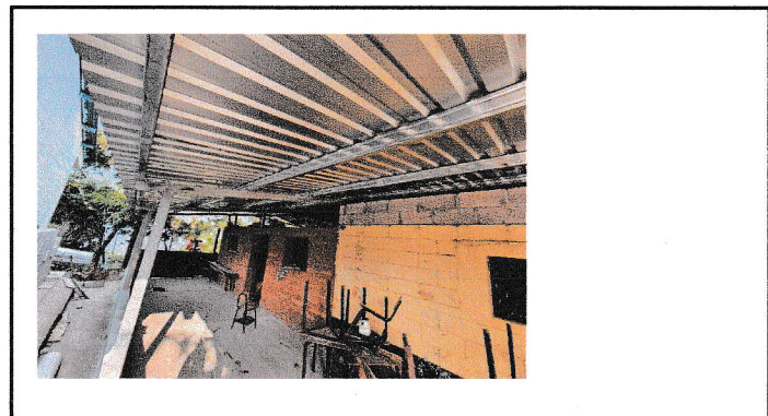
Foto 4: CAMBIO DE LAMINA DEL AULA TERMINADA
