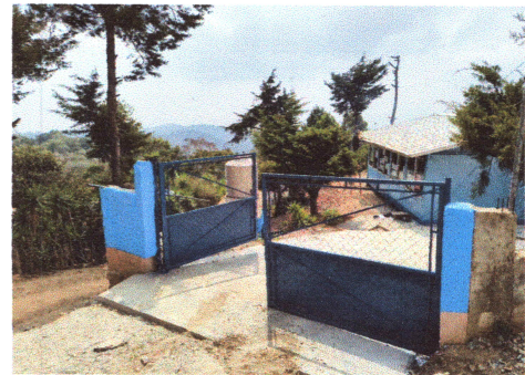
Foto 4: Mantenimiento a porton
