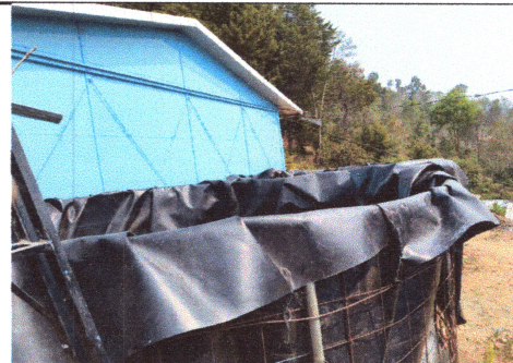
Foto 6: Mantenimiento de deposito de agua.
