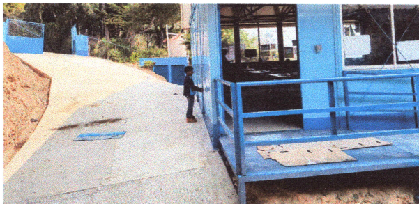
Foto 5: Losa de patio concluida
