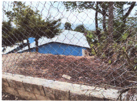
Foto 3: Reparacion de Cerco
