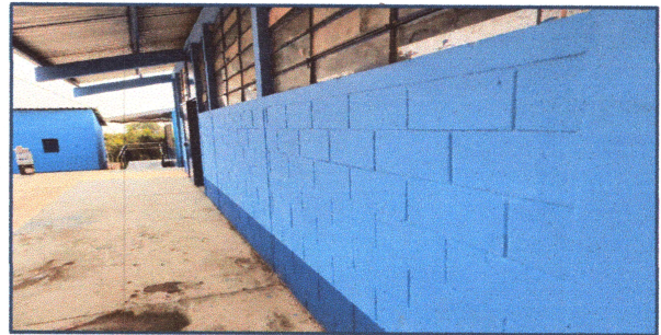
Foto 2: pintura en muros interior y exterior
