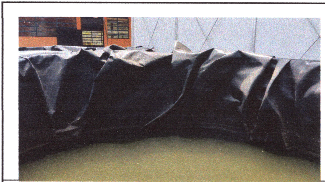
Foto3: SISTEMA DE AGUA EN MAL ESTADO
