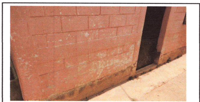
Foto: 6 DETERIORO DE LA PINTURA EN LAS PAREDES DEL ESTABLECIMIENTO
