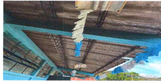
Foto 2: LAMIANA EXISTENTE DETERIORADA SUSTITUCION
