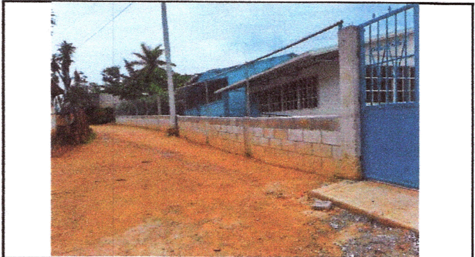
FOTO 2: Mantenimiento de portones
