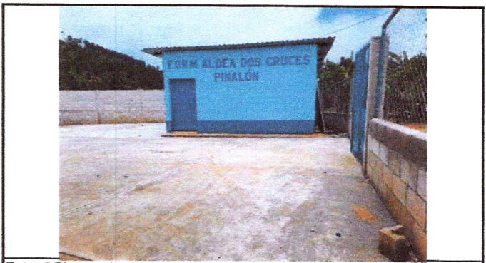
Foto: 6 Pintura de muros y exteriores
