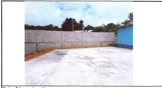
Foto: 5 Losa de patio
