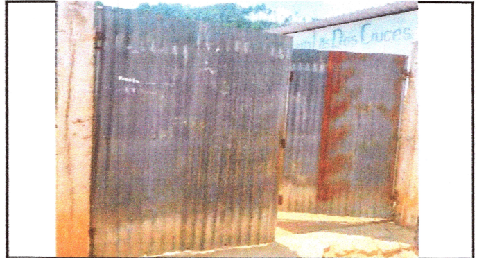
FOTO 2: Mantenimiento de portones
