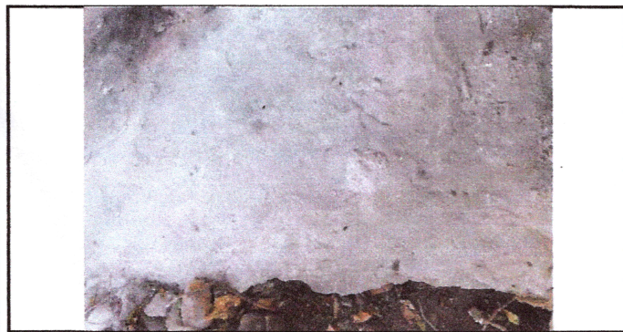
Foto: 5 Losa de patio
