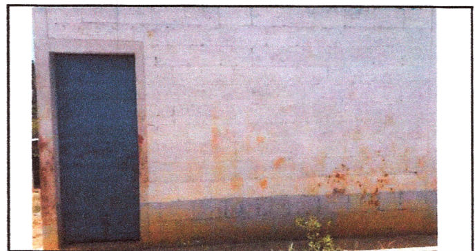
Foto: 6 Pintura de muros y exteriores
