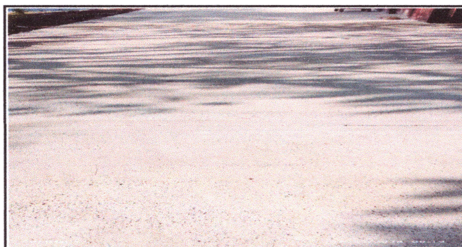
Foto 5: Reparación de losa
