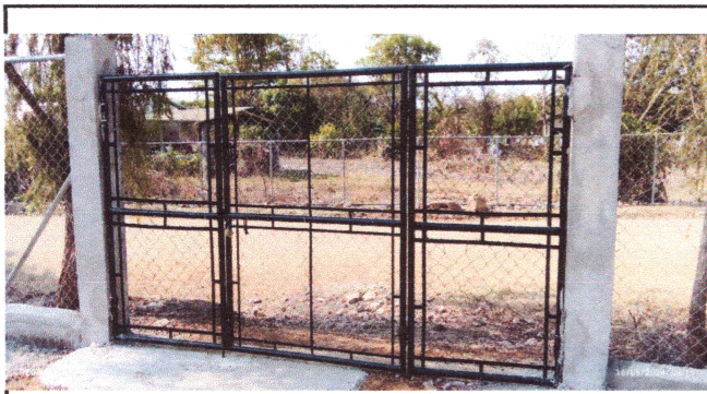
Foto 3: Reparación, ampliación y pintura de porto
