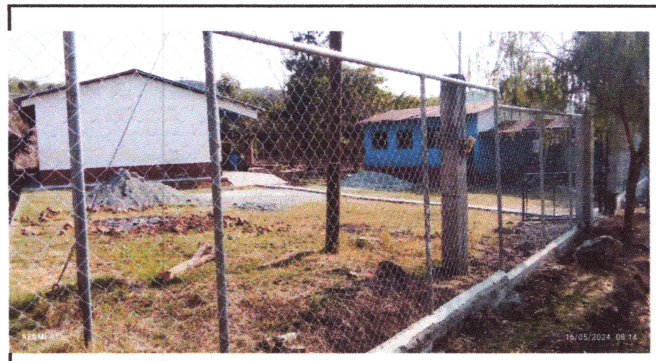
Foto 4: Cambio de Malla en muro
