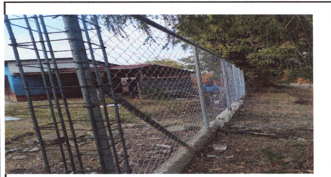
Foto 3: Reparacion y Ampliacion y pintura de porton
