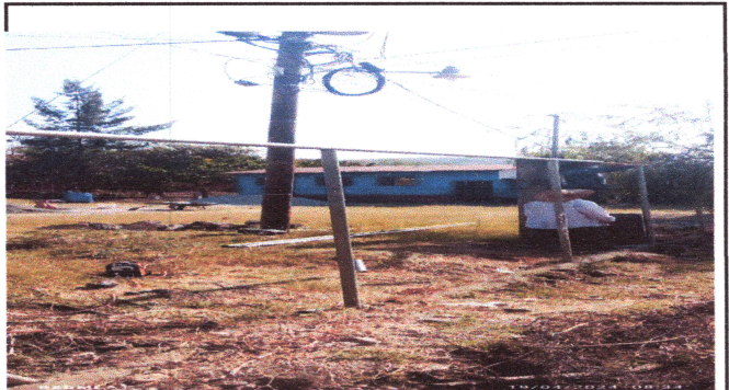
Foto 4: Cambio de malla en muro
