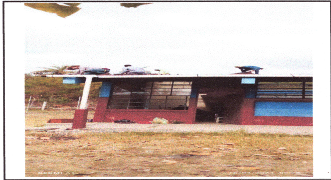
Foto1: Reemplazo de Lamina
