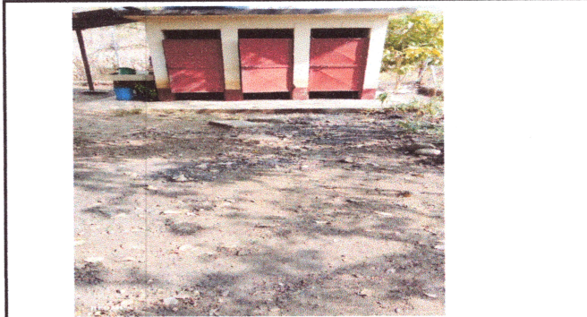
FOTO 2: CONSTRUCCION DE FOSA SEPTICA
