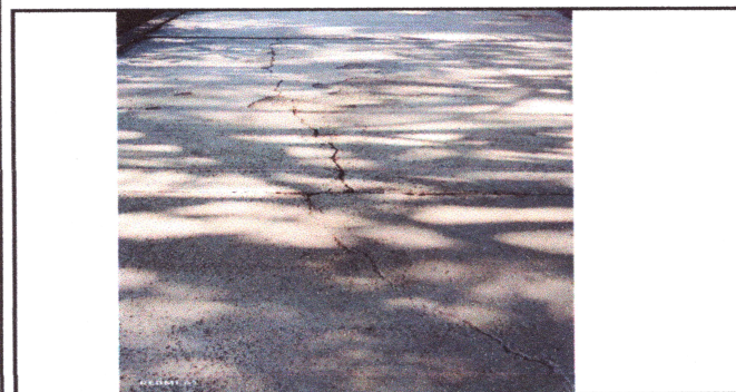
Foto: 5 REPARACION DE LOSA
