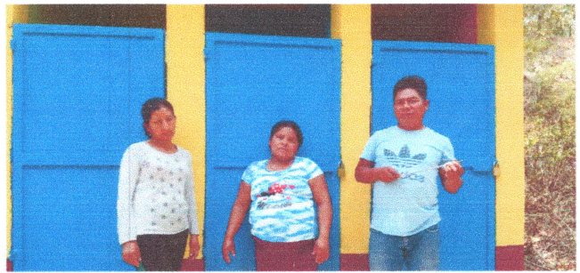
Foto 4: Puertas reparadas verificada por comunidad educativa
