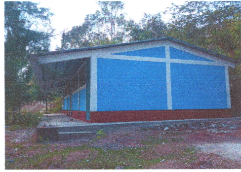
Foto 6: Finalización de trabajo en la escuela.
