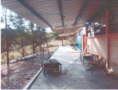
Foto 1: Desmontaje de canaleta
