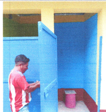
Foto 4: Verificación de puertas reparadas
