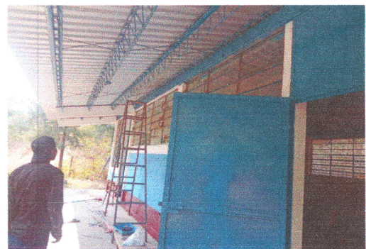
Foto 6: Finalización de puertas reparadas.
