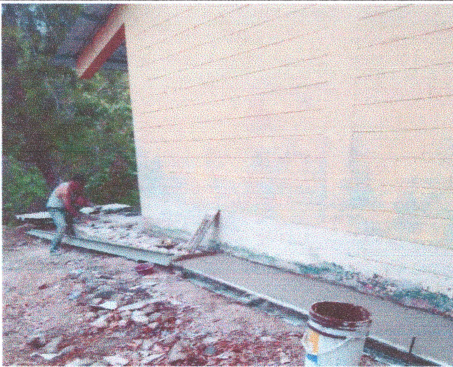
Foto 3: Fundición de banqueta
