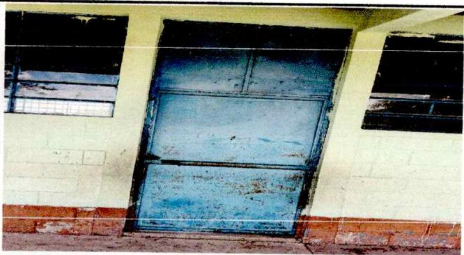
Foto 5: SE OBSERVA EL MAL ESTADO DE LAS PUERTAS, SE APLICARÁ REPARACIÓN.
