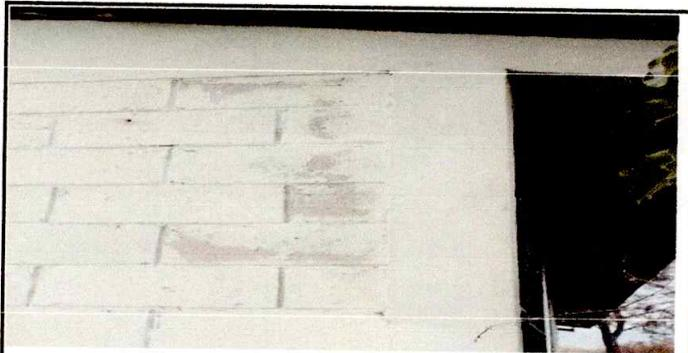
Foto 6: SE OBSERVA PAREDES CON PINTURA DETERIORADA
