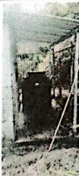
Foto 5: Galera que protegera la cisterna de agua, torta de piso de 8 cms de espesor y cisterna para agua.
