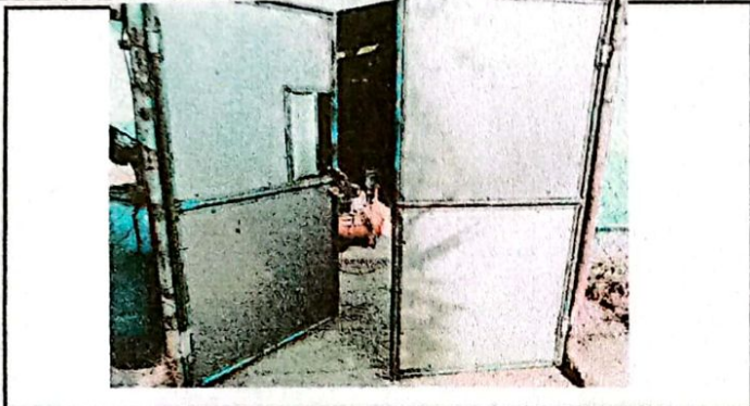
Foto1: restauracion del porton que se encontraba en mal estado
