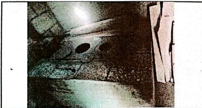
Foto 3: Cocina rustica en mal estado chimenea de metal oxidada y caída, plancha caída.
