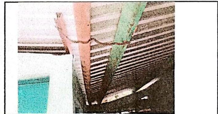
Foto 4: Cznal de pvc, y pescantes en mal estado
