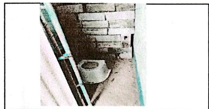
Foto 6: Sanitario tipo letrina en mal estado y despegado, pared de blocks sin pegar, sin columnas y puerta de lamina corriente.
