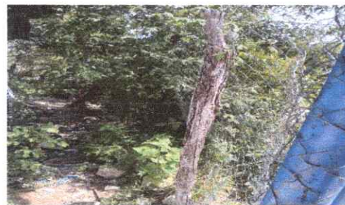
Foto 2: SUSTITUCION DE CERCO PERIMETRAL CON BLOCK Y MALLA
