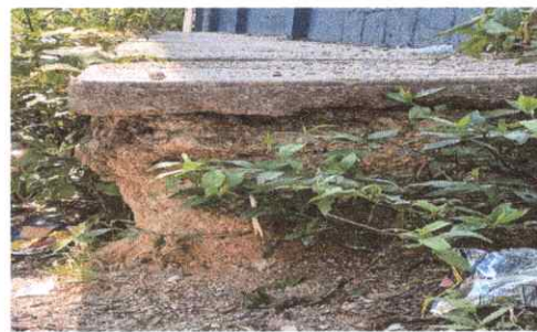
Foto 4: SUSTITUCION DE LOSA DE PATIO INCLUYENDO FUNDICION Y ACABADO
