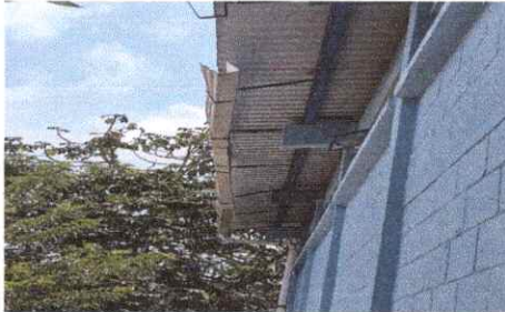
Foto 1: CANALES Y BAJADAS DE AGUA PROVIAL
