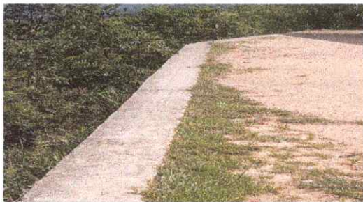
Foto 3: SUSTITUCION MURO PERIMETRAL BLOCK CISADO MAS COMUNAS DE CONCRETO ENSABIETADAS
