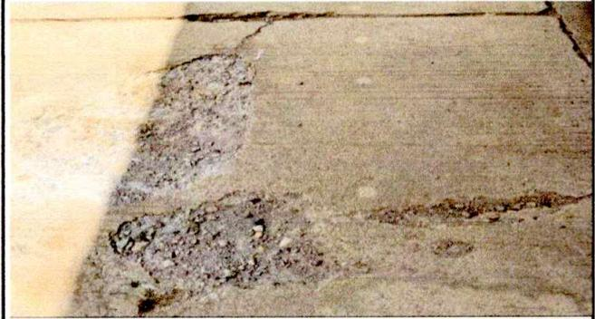
**FOTO 2: ES NECESARIO SUSTITUIR LA LOSA DE PATIO**
