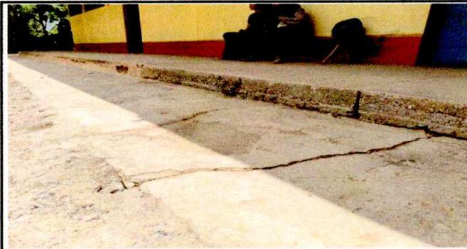
**Foto 3: SE OBSERVA LA LOSA DE PATIO EN MAL ESTADO.**
