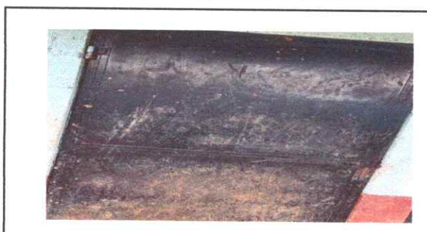
Foto 4: Sustitución portón de tubo con lámina.
