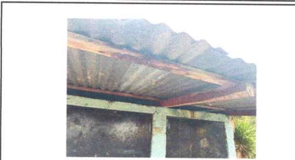
Foto 1: Cubierta de lámina
