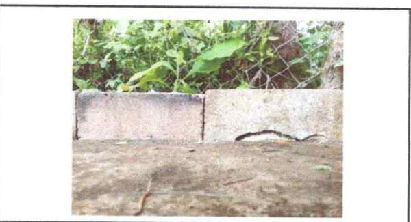
Foto 5: Reparación cerco perimetral
