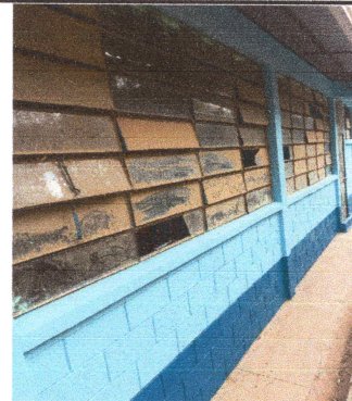
Foto 4: Finalización de pintura.
