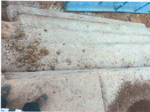
Foto 3: Finalización de gradas
