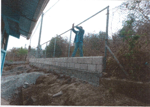
Foto1: Finalización de muro de maya.
