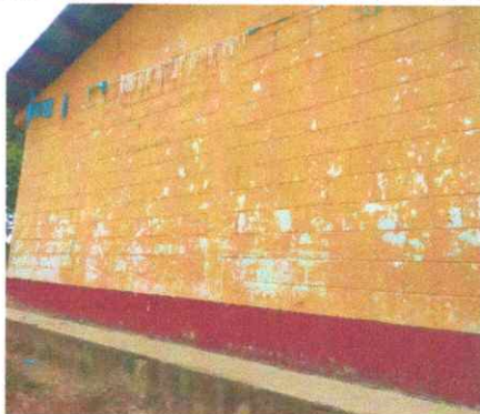
Foto1: Sustitución de pintura base agua
