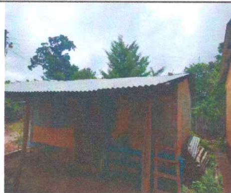
Foto 4: Sustitución lámina troquelada calibre 26
