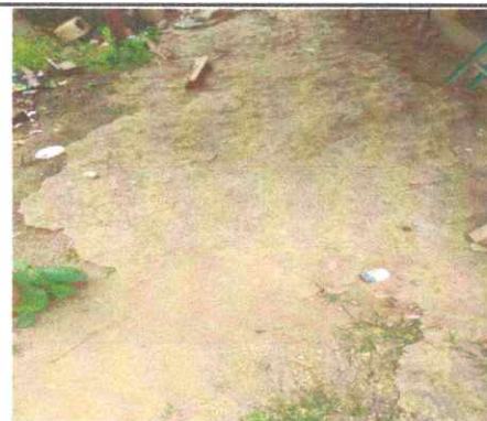
Foto 6: Sustitución losa de patio
