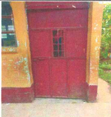
Foto 3: Reparación y mantenimiento en puertas en area de aulas
