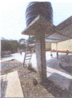
Foto 5: tubería de baño y deposito reparada
