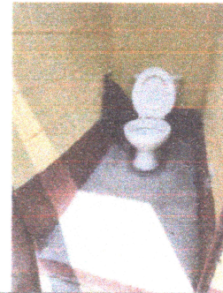
Foto 4:Sanitario nuevo terminado
