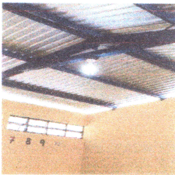
Foto 3: Instalacion de energia y focos nuevos
