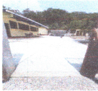
Foto 2: Losa de patio terminada
