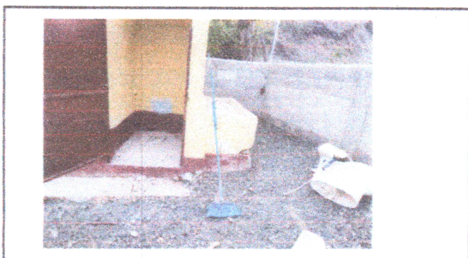
Foto 4: proceso de cambio de sanitario
