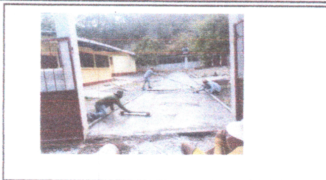
Foto 2:Proceso de fundicion losa de patio
