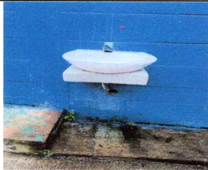
Foto 3: Sustitución de lavamanos con pedestal.
