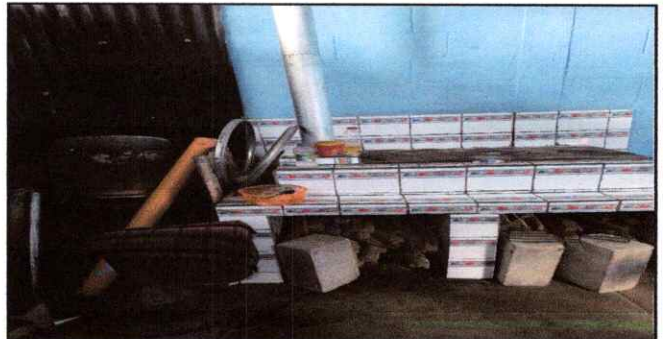
Foto 6: Reparación de área de cocina, estufa rural y sustitución de mesones.
