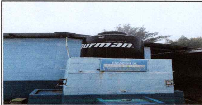
Foto 5: Sustitución de depósito de agua tipo rotoplas de 1200 litros.
