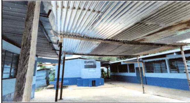
Foto 1: Desmontaje de lámina acanalada y sustitución de la misma por lámina troquelada calibre 26, instalación de soporte de estructura, así mismo sustitución de la escritura de madera a estructura de metal.
