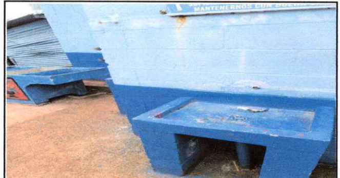
Foto 4: Sustitución de red de agua potable tubería de 1/2 pvc incluyendo accesorios.
