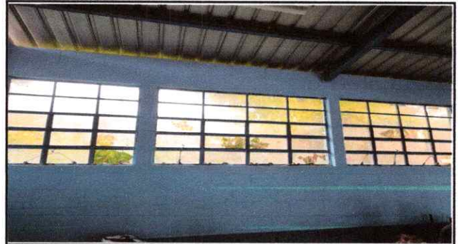
Foto 2: Sustitución de vidrios medidas típicas.
