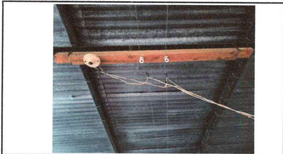
Foto 13: Reparación de sistema eléctrico (sustitución).
