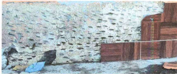
Foto 5: Sustitución de piso cerámico
