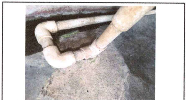
Foto 14: Reparación y mantenimiento de depósito de agua (sustitución).
