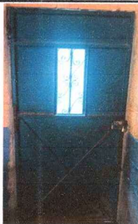
Foto 3: Sustitución de puerta de aula.
