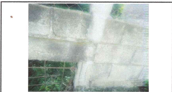
Foto 11: Cerco o muro perimetral (sustitución con block).
