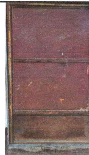
Foto 4: Sustitución puerta de baño.
