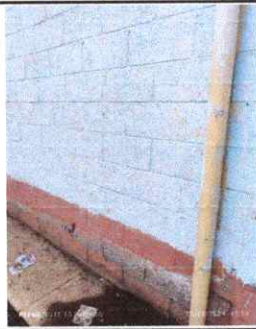
Foto 3: Pintura: Pintura en muros interiores y exteriores
