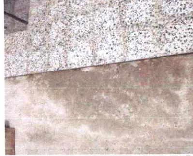
Foto 2: Piso: Sustrucción de piso de Granito
