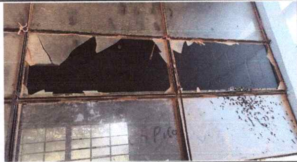
Foto 1: Ventanas: Sustrucción de vidrios
