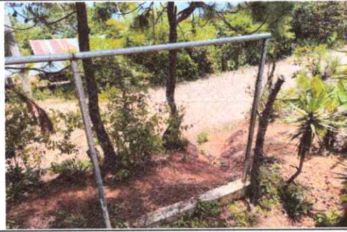
Foto 4: Cerco o Muro Perimetral: Sustrucción de cerco perimetral con block y malla
