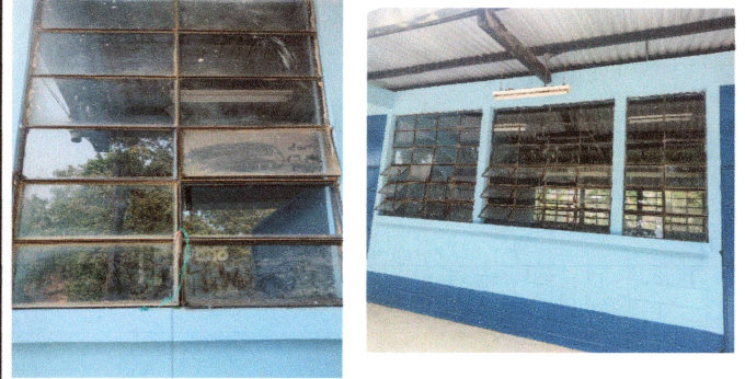
Foto 2: Se finalizó de colocar los vidrios en las ventanas
