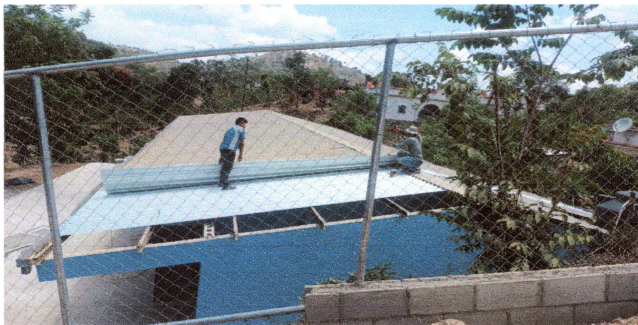
Foto 5: Se cambiaron láminas del techo de los sanitarios
