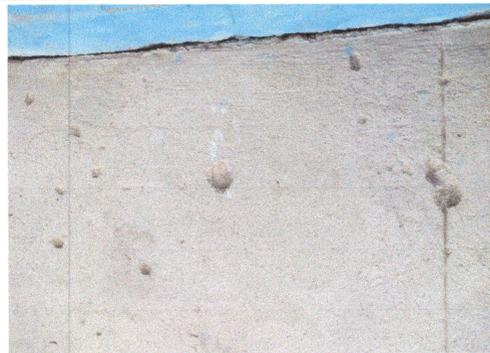
Foto: 6 Se evidencia losa de patio en mal estado
