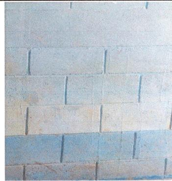
Foto4: Se observa paredes con pintura deteriorada
