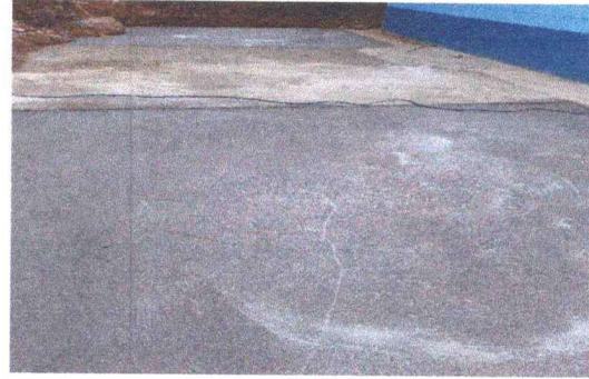
Foto 2: Sustitución Losa Patio
