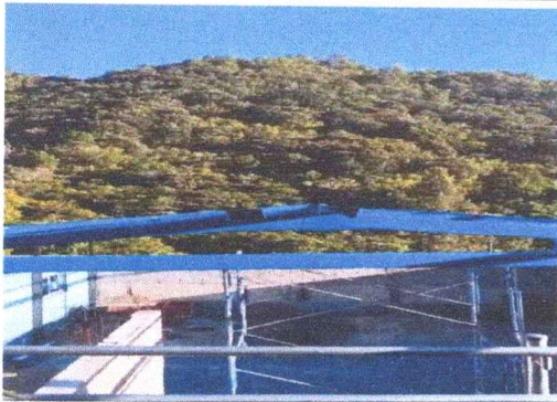
Foto 3: Sustitución de estructura techo.
