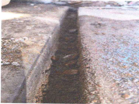
Foto 1: Sustitución de Cuneta de Concreto
