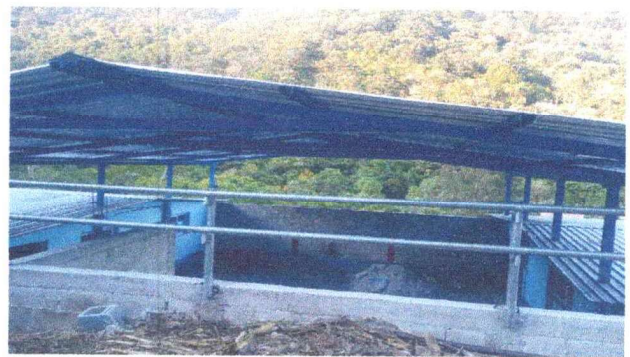
Foto 4: Sustitución lamina troquelada calibre 26
