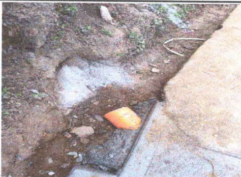
Foto 5: Sustitución de Red de Drenajes PVC4" incluye accesorios
