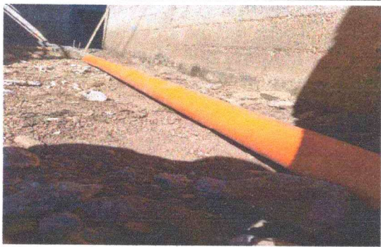
Foto 5: Sustitucion de Red de Drenajes PVC4" incluye accesorios
