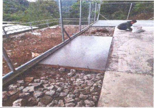
Foto 2: Sustitucion Losa Patio
