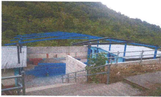
Foto 3: Sustitucion de estructura techo.
